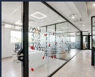
Nous mettons en oeuvre les produits de notre partenaire historique QOVANS et plus particulièrement sa marque CLIPS. Il s'agit de systèmes polyvalents dotés d'une ossature en aluminium laqué permettant une diversité de configurations : cloison pleine ou vitrée, toute hauteur, sur allège ou avec imposte, en montage sous couvre-joint, en bord-à-bord ou à joint creux..., tout en offrant d'excellentes performances acoustiques.
